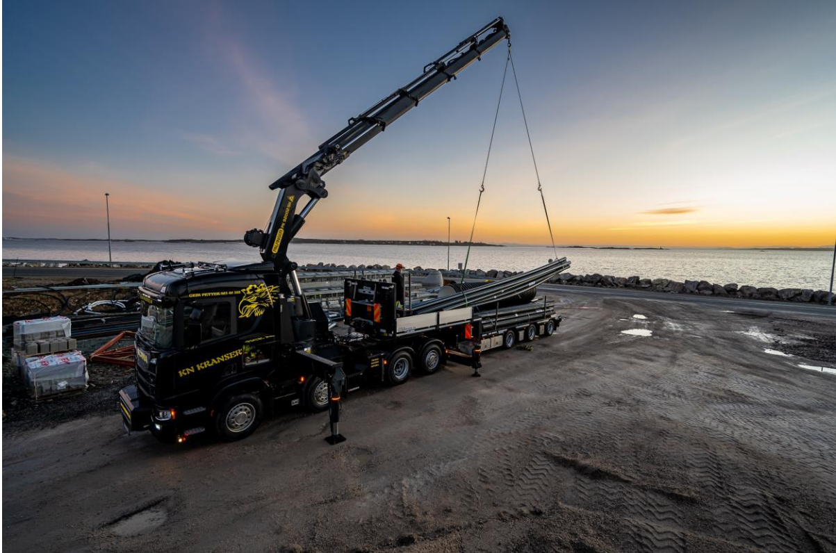
Bilde: Fra oppstart av prosjektet. Foto: KN Entreprenør AS
