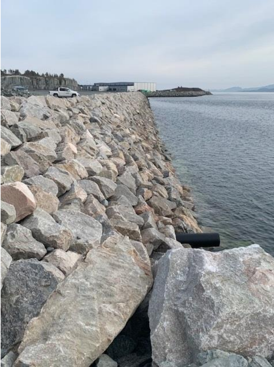
Bilde over: Plastringsstein mot sjø. Plastring (steinplastring) er en teknikk som brukes for erosjonssikring, hvor man dekker skjæringskråninger, elvebredder eller fyllingsdammer med et lag av flate steiner. Formålet er å hindre at strømmende vann, bølger eller vind graver ut jordmasser (erosjon).
