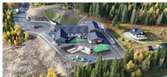
Det er lagt ny forsyning av rør for vann, avløp og overflatedrenering til barnehagen og langs siste del av Hotellveien. Området er dimensjonert for videre utbygging.
