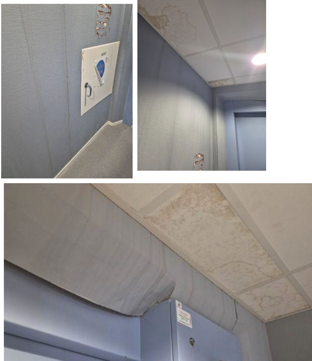
Figur 3. Bilder som viser tilstand i deler av bygget
