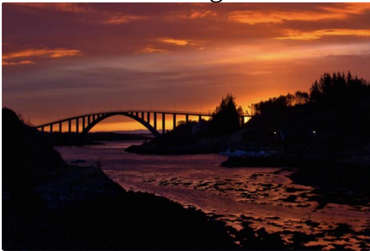
Hildring, Uttian bru. Foto: Elin Reppe
