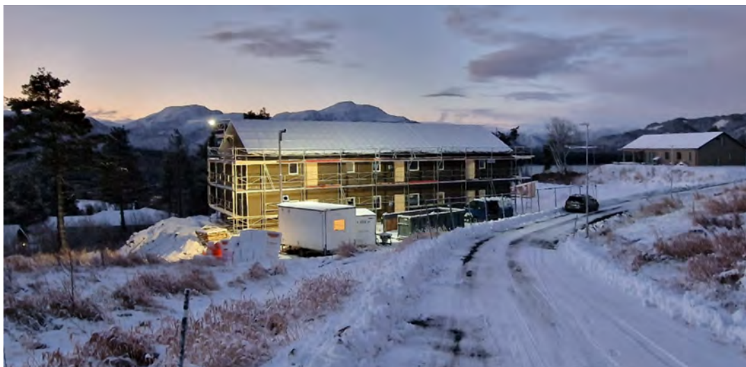
6-mannsbolig Liabø tett tak uke 48
