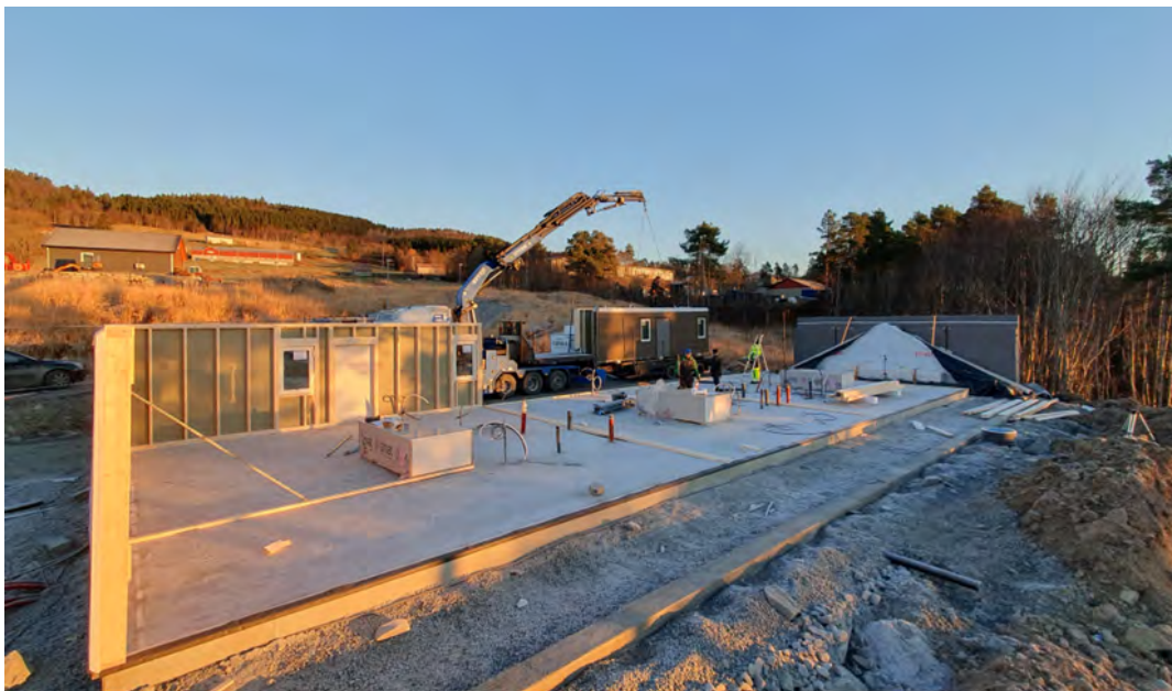
6-mannsbolig Liabø start montering av vegger
