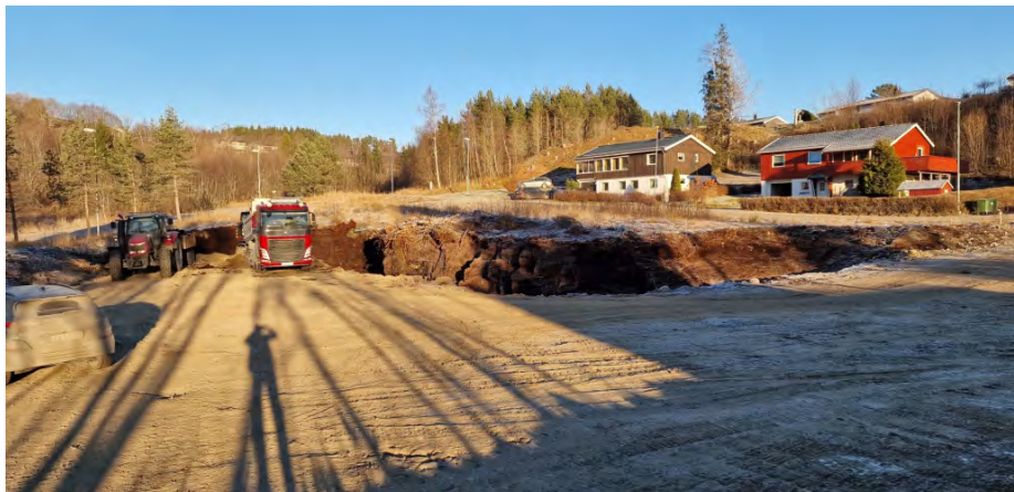
Boligutviklingsprosjekt Tørrstuveien - pågående masseutskifting
