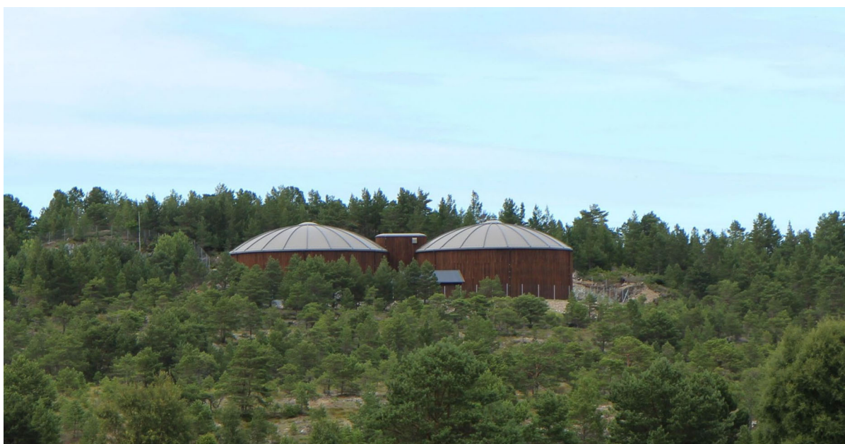
Høydebassenget ved Strandavatnet
