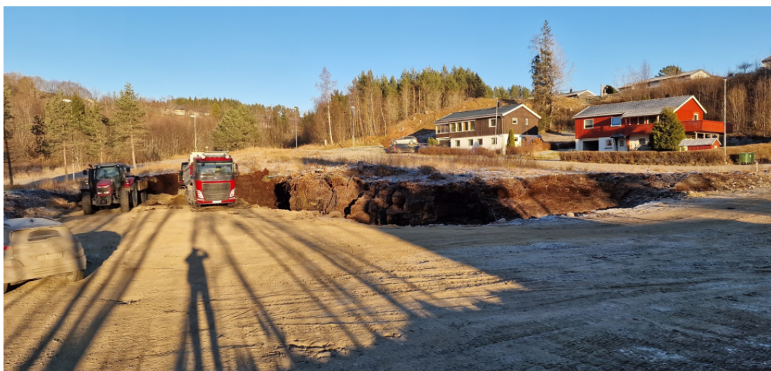
Boligutviklingsprosjekt Tørrstuveien - pågående masseutskifting
