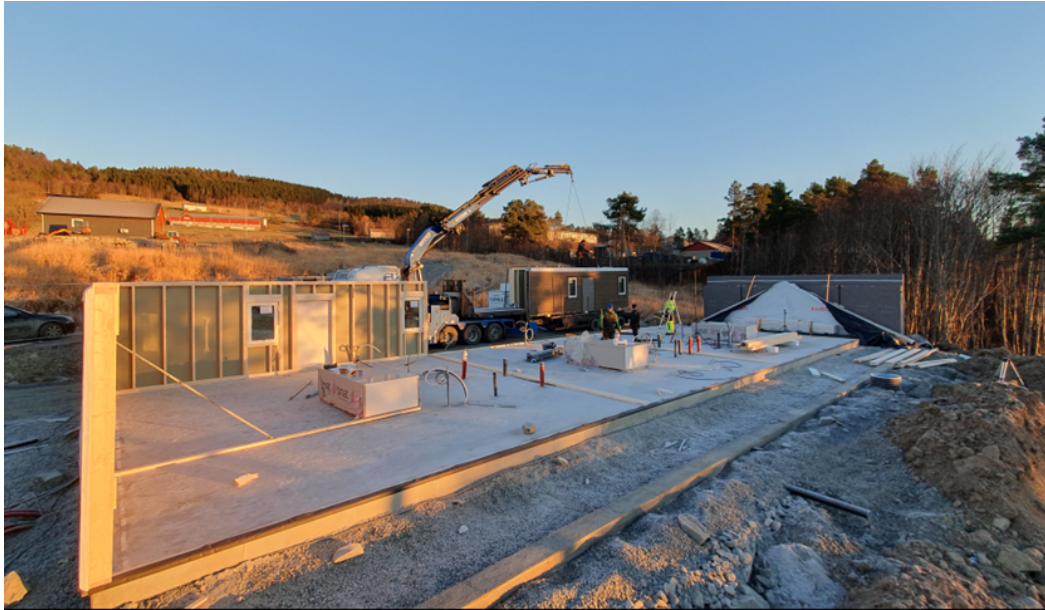
6-mannsbolig Liabø start montering av vegger
