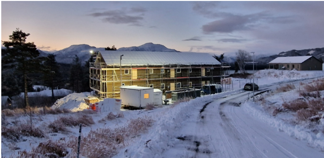
6-mannsbolig Liabø tett tak uke 48
