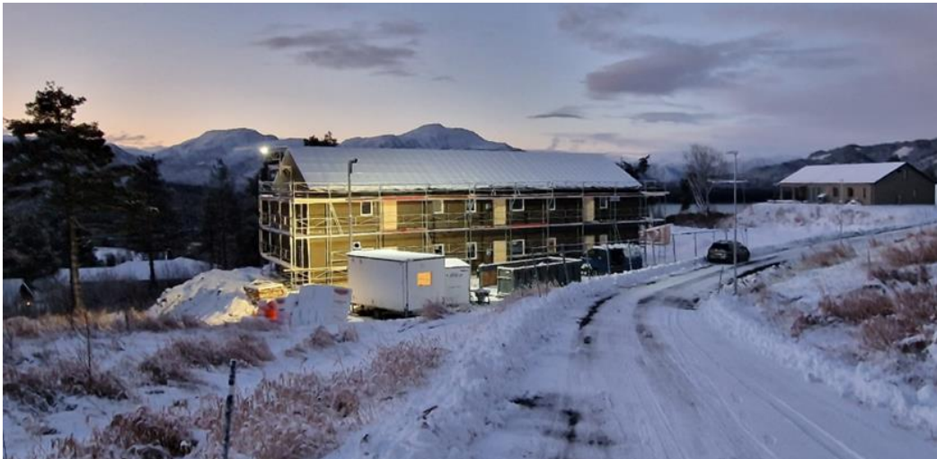
6-mannsbolig Liabø tett tak uke 48
