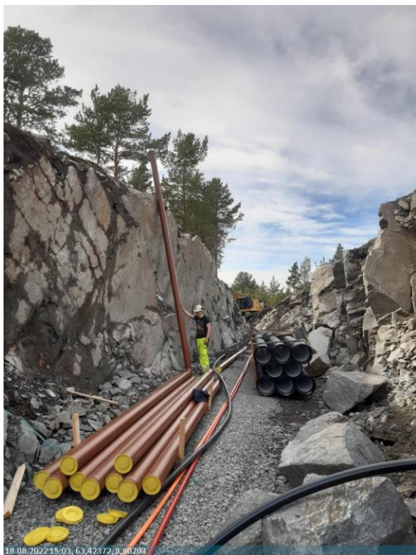
Avløpsanlegg Taftøyen - gjennom fjellskjæring
