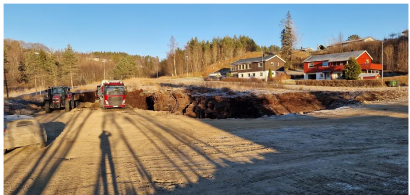
Boligutviklingsprosjekt Tørrstuveien - pågående masseutskifting
