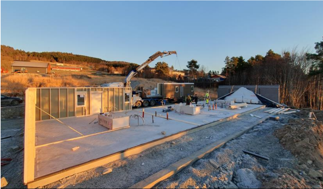
6-mannsbolig Liabø start montering av vegger
