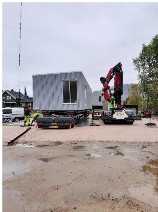
Boligmodul fra Gloria Husvogn under montering i Fosseveien
