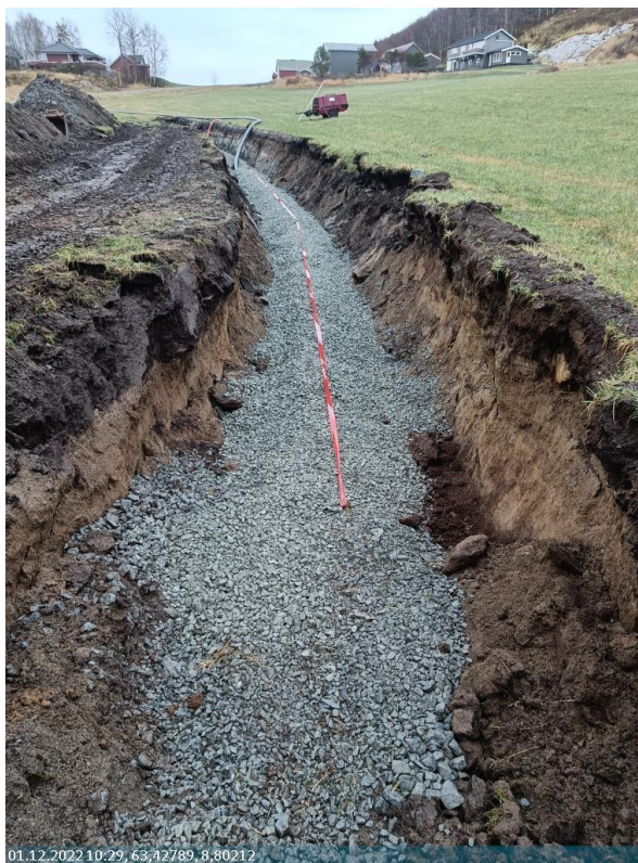
Avløpsanlegg Taftøyen - ledningsnett over dyrka mark
