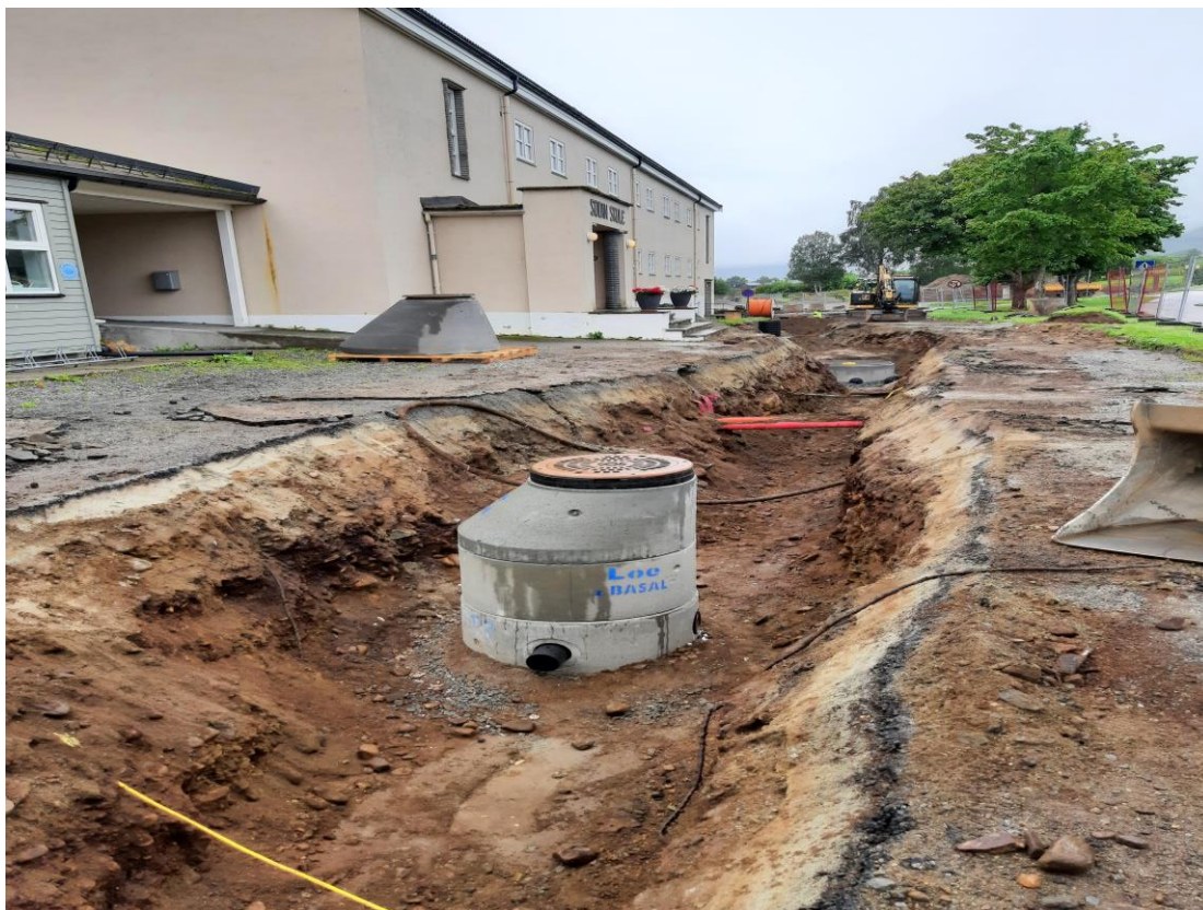
Sodin trafiksikkerhet - vann og avløpsarbeid foran A-fløya
