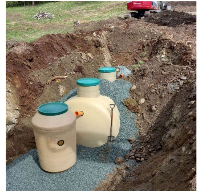
Bygge nytt avløpsanlegg
