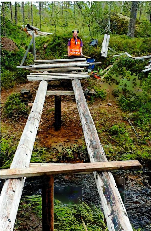
Leif i full gang med å lage ny bru ved Andorvatnet.
