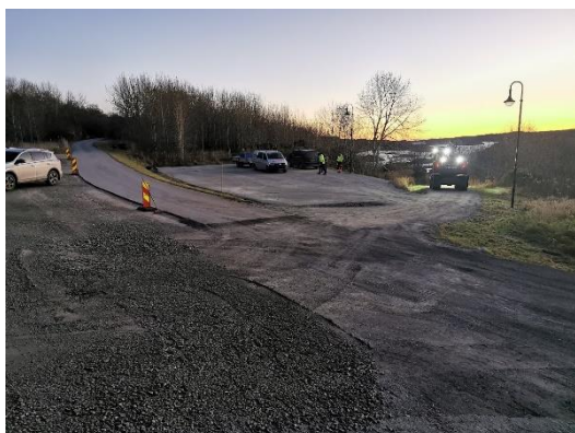
Parkering og vei under asfaltering i 2022
