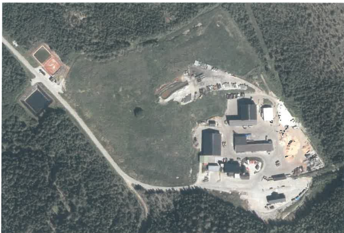
Deponiet utgjør 55 dekar av til sammen 120 dekar på Stormyra
