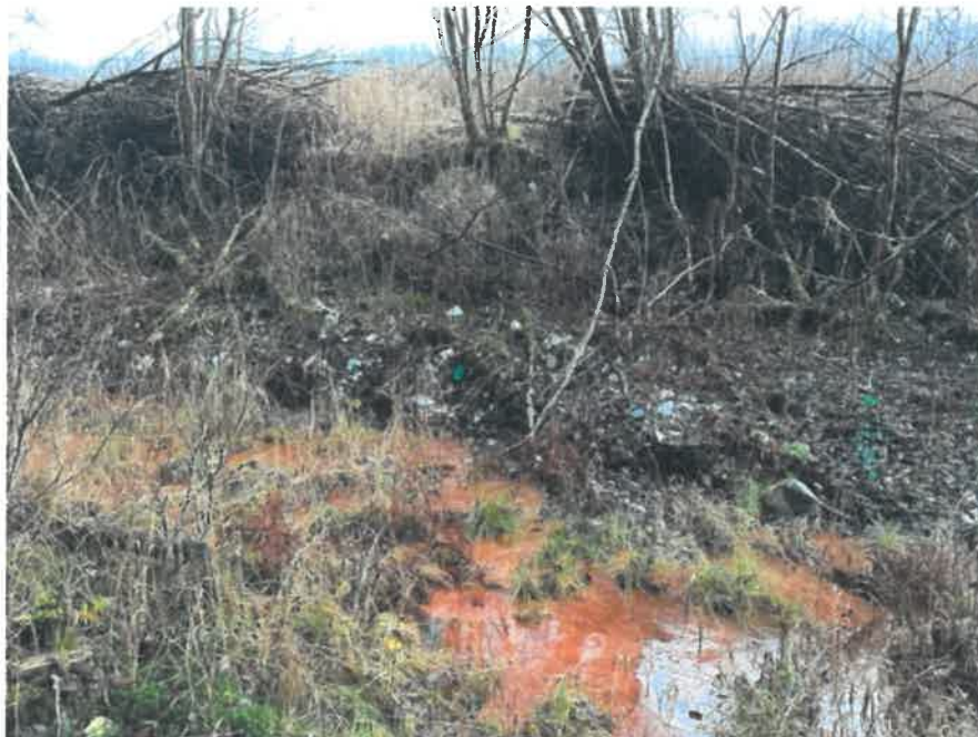
Tildekking av bratt skråning er mangelfull. Lekkasje fra deponiet.
