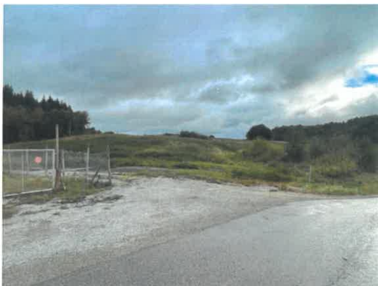
Den nord-vestlige delen av deponiet. Bildet tatt fra renseanlegget
