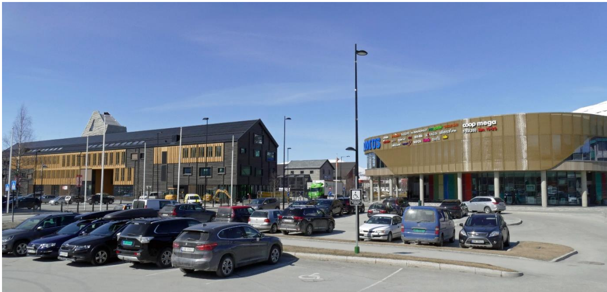
Oppdal sentrum – Ferdigstillelse av nye forretningsbygg 2021
