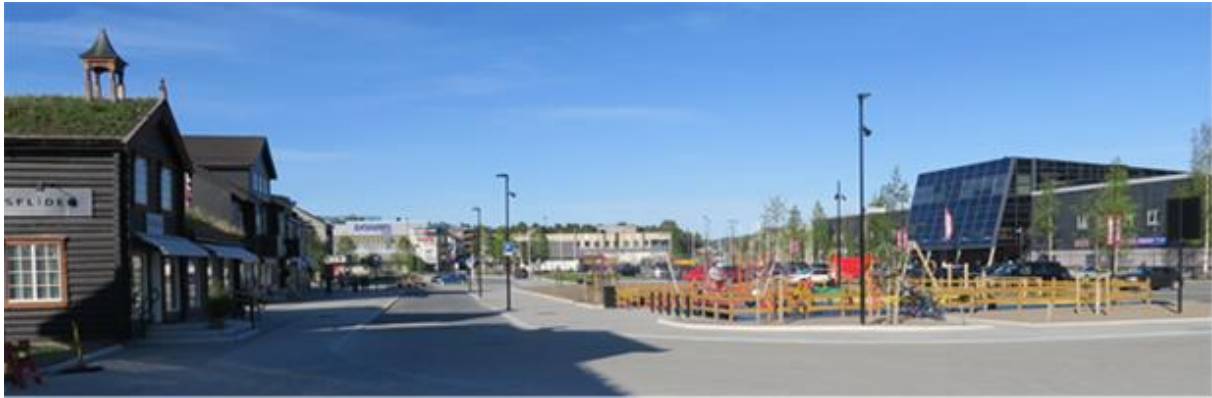
Oppdal sentrum – Ferdigstillelse av ny sentrumsgate 2018
