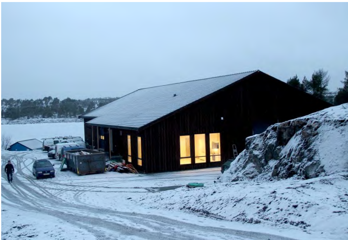
Foto: Vannbehandlingsanlegget på Strandavatnet, Sandstad (bilde fra Hitra-Frøya)
