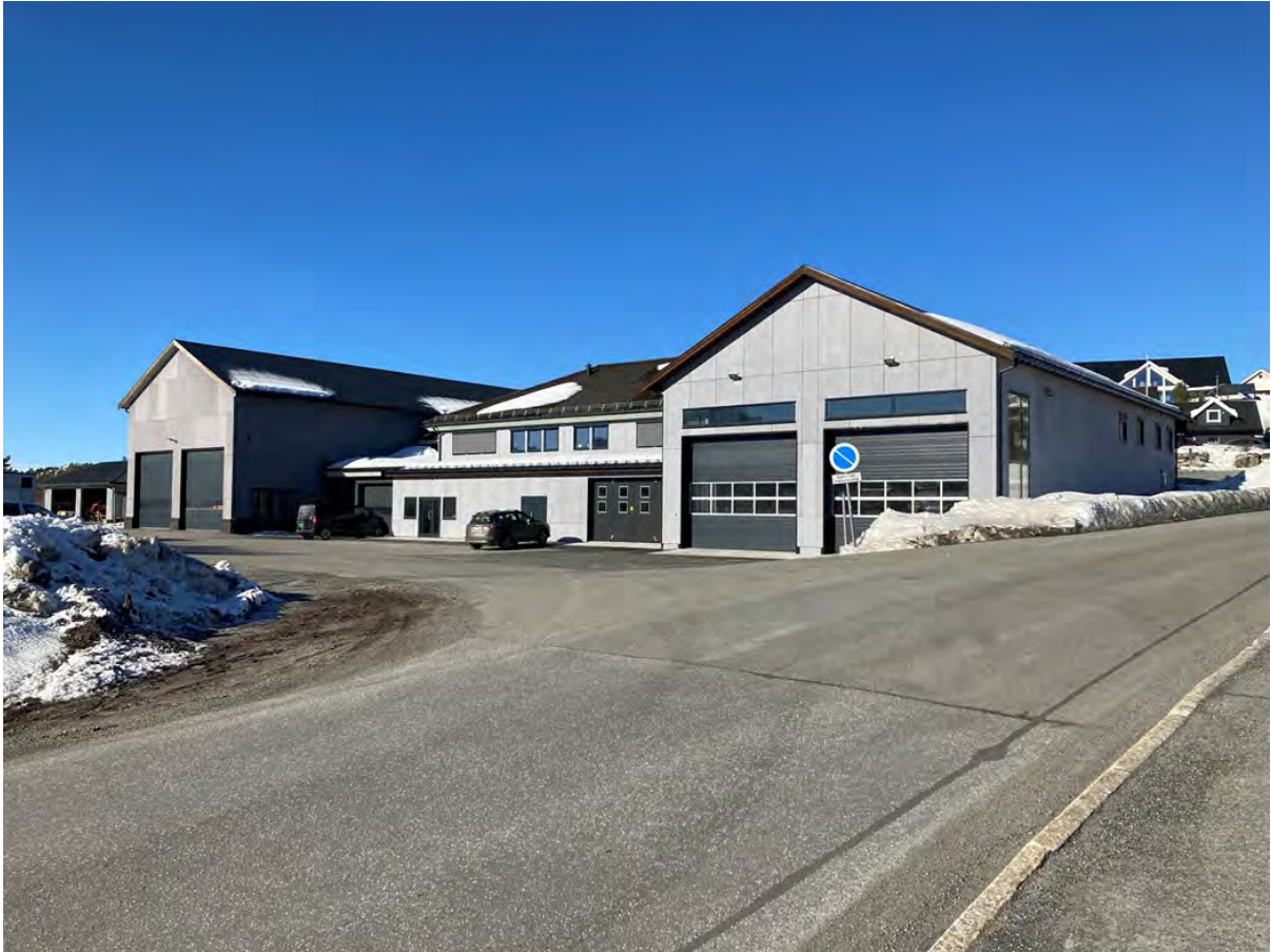
Bilde: Nye Fillan brannstasjon som ble ferdigstilt i oktober 2022.
