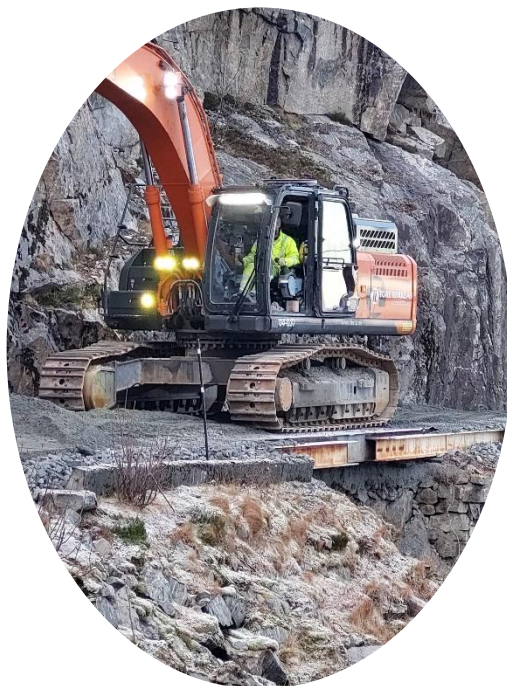
Arbeid med Setransveien
