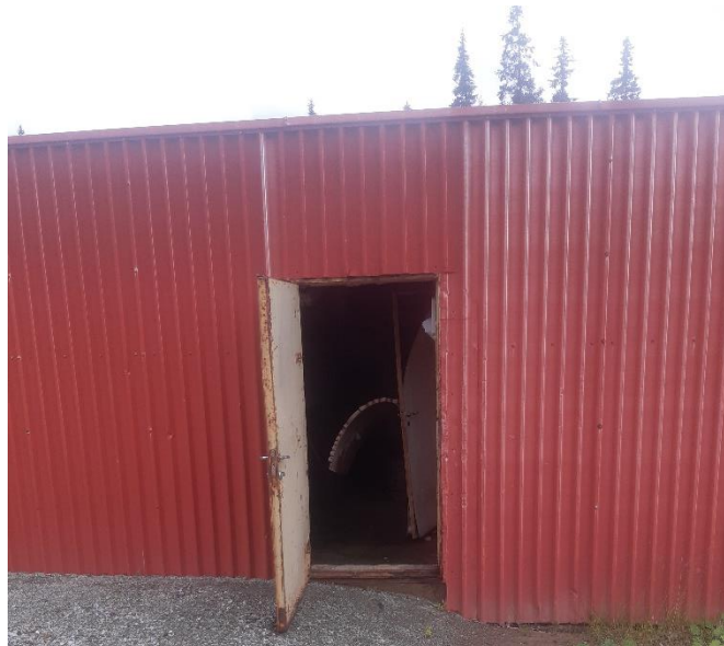
Dør til oppredningsverksted med avrustede hengsler
