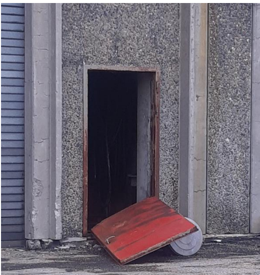
Dør til oppredningsverksted med avrustede hengsler
