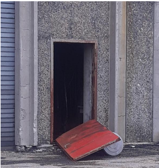
Dør til oppredningsverksted med avrustede hengsler
