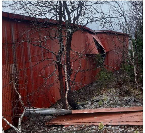
Snekkerverksted / lager sammentrykt og knekt
