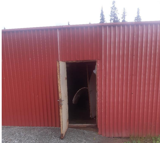
Dør til oppredningsverksted med avrustede hengsler
