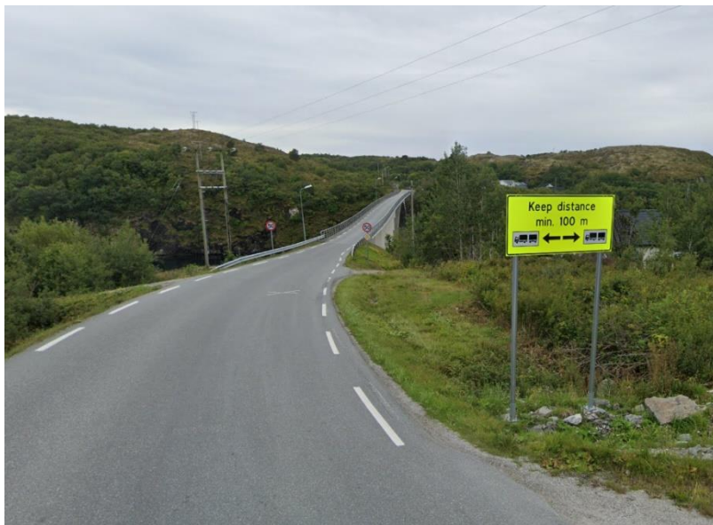
Figur 22: Knarrlagsundbrua er ett kjørefelt med bredde på 4,2 m. Kilde NVDB
