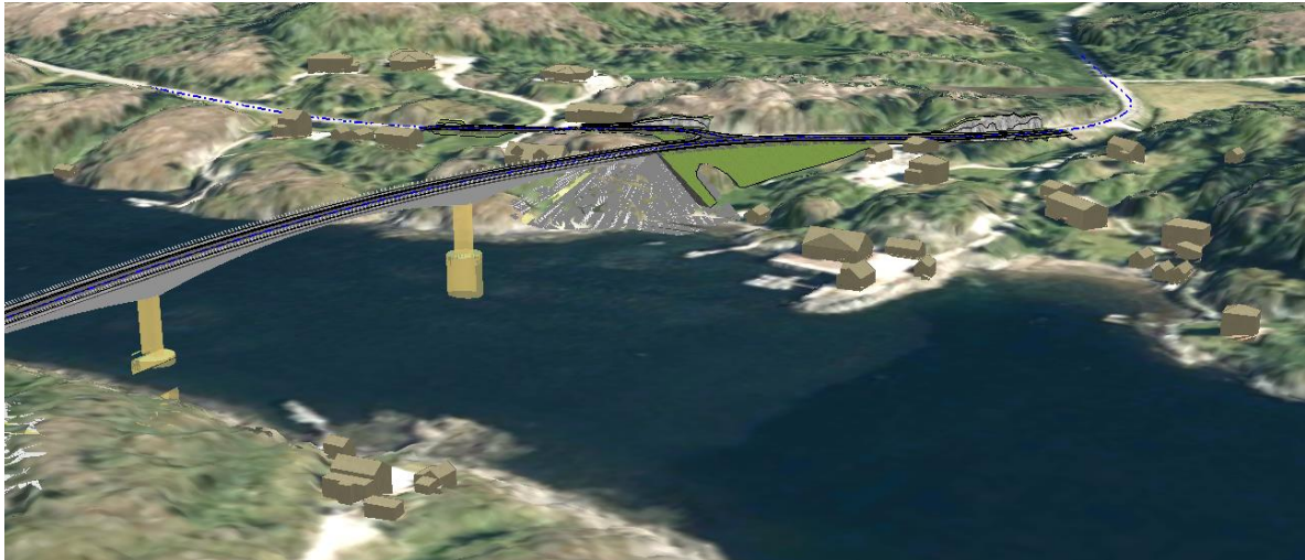
Figur 16: Alt. vest - fyllinger på sørsiden av ny bru (illustrasjonen er fra nord mot sør).
