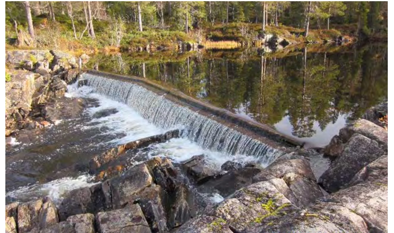
Eksisterende terskel i Tunnsjøelva
