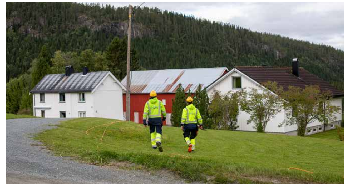
NTE har mange bygdefiberprosjekt. Her er to elektrikere på jobb i Gåsbakken.
