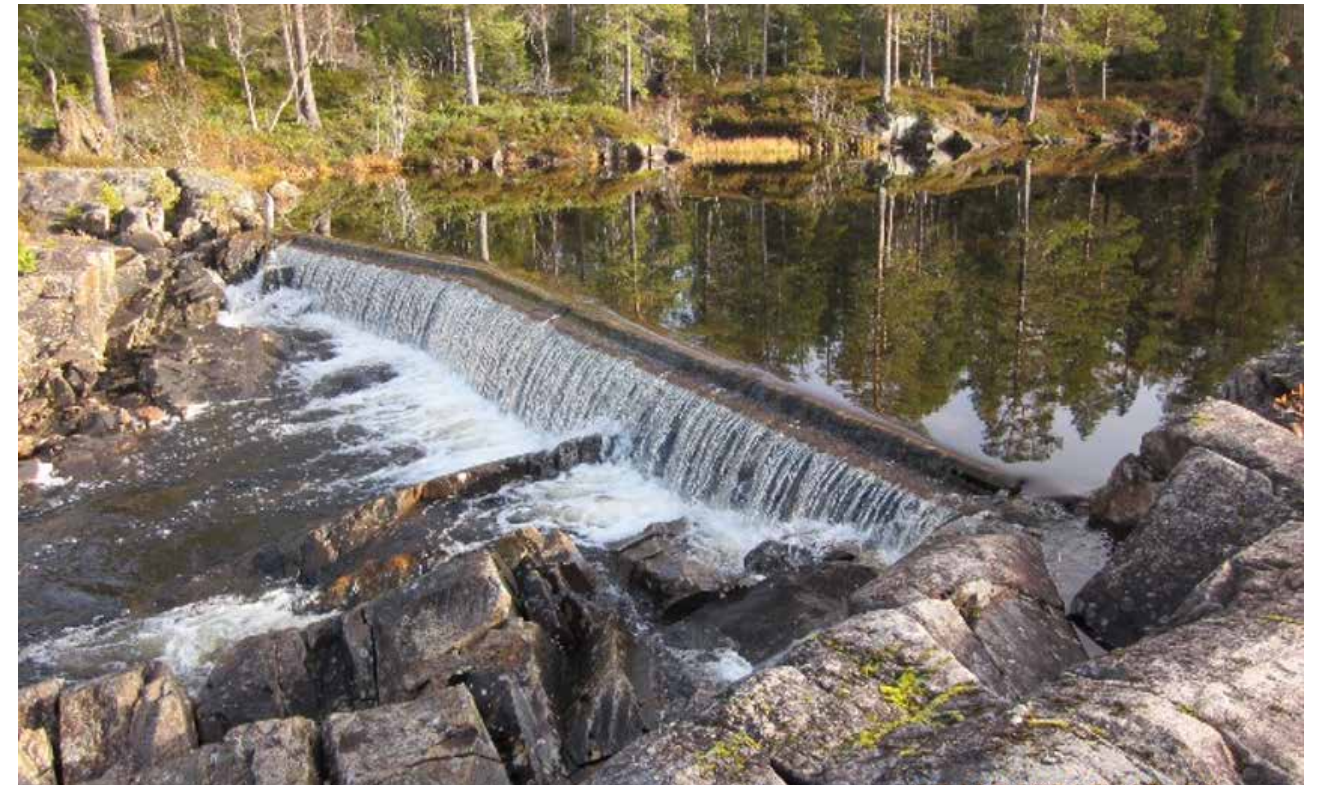
Eksisterende terskel i Tunnsjøelva
