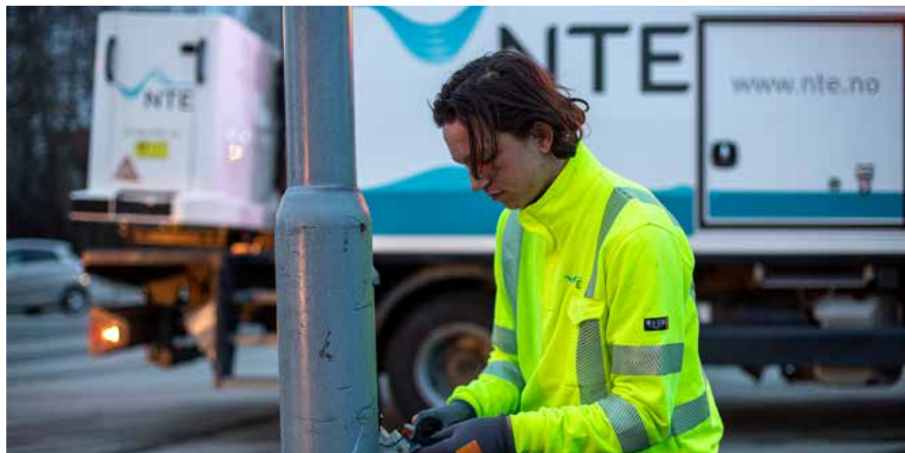
Magnus Fraser monterer smarte gatelys i Sjetnemarka for Trondheim kommune.
