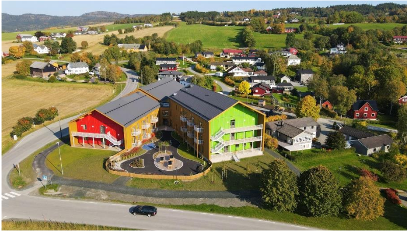
Stadsbygd omsorgssenter stod ferdig 01.09.2020
