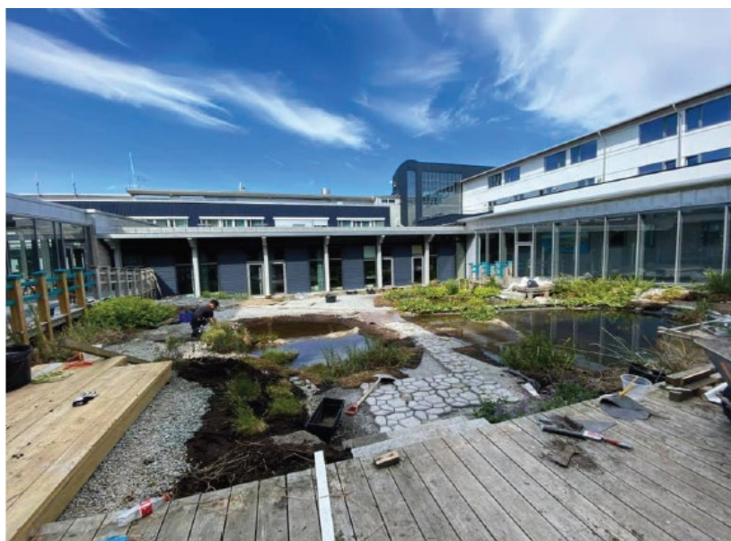
Foto: Våtmarkshagen under ferdigstilling.
